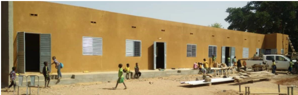
Bild: Die sanierte Schule wird in Augenschein genommen.
